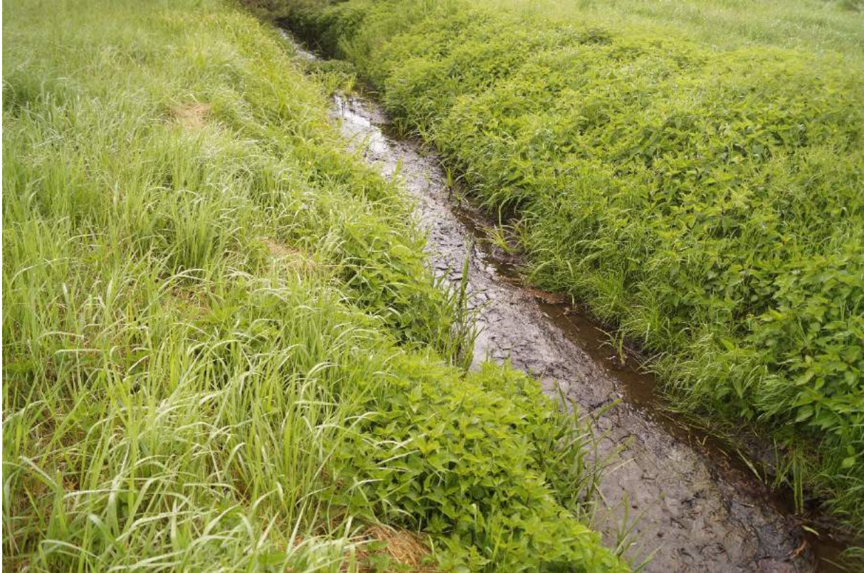
Abb. 11: verschlammter Klingmühler Mühlgraben
